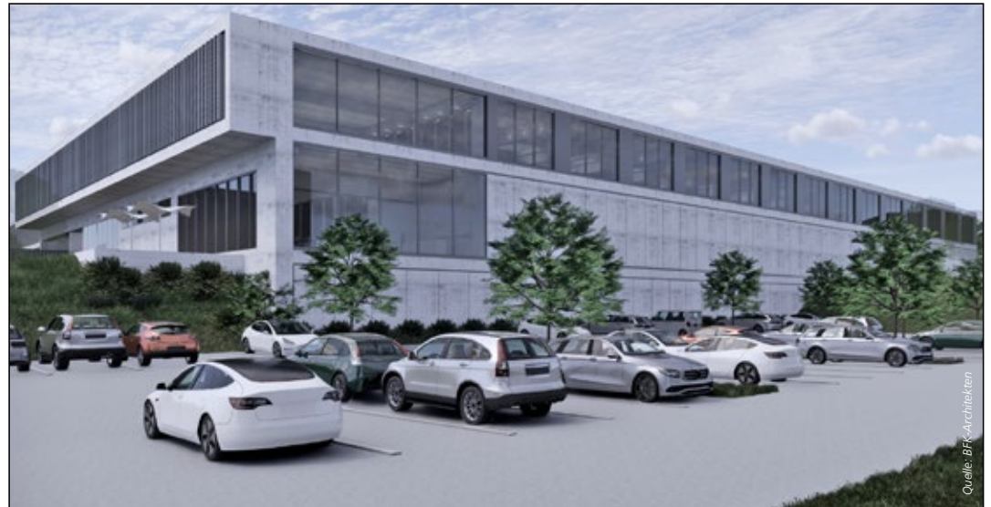
Hübsch anzusehen und bereits im Bau ist die neue Layher-Halle
