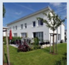
Reihenhäuser Grundstückseigentümer: u.a. Stadt Heidelberg; Pfälzer Katholische Kirchenschaffnei
