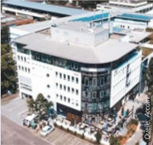
117 unter- und oberirdische Stellplätze. Zwei Jahre dauerten die Arbeiten, in denen der Instandhaltungstau beseitigt, unter anderem eine Betonsanierung in der Tiefgarage durchgeführt, die Fassade überarbeitet, die Haustechnik teilweise erneuert und die Arbeitsbereiche neu gestaltet wurden.
