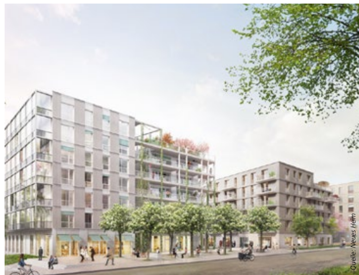
Gestiegene Neubaukosten lassen auch das IBA-Projekt Quartier am Rotweg nicht unberührt. 250 bis 280 Wohnungen sind geplant, zuzüglich Gewerbeflächen und einer inklusiven Kindertagesstätte
