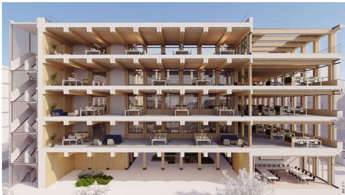
Gefertigt in innovativer Holzmodulbauweise
