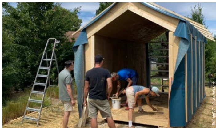
Eines von drei Jokerhäusern für flexible Nutzung
