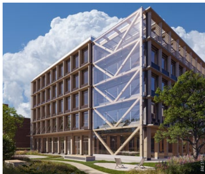
Minimale Haustechnik in den Obergeschossen
