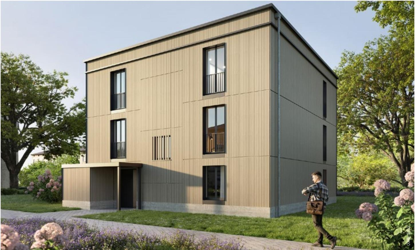
Die Fassade besteht aus Holz, auf einen Keller wird verzichtet
