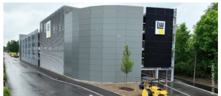
Das neue Parkhaus mit vielen PV-Modulen
